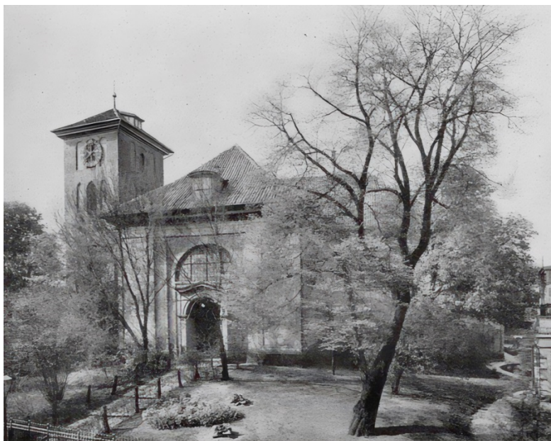
Храм в Трагхайме (1710—1723). Архитектор И. фон Унфридт. Фото. Начало XX в.
