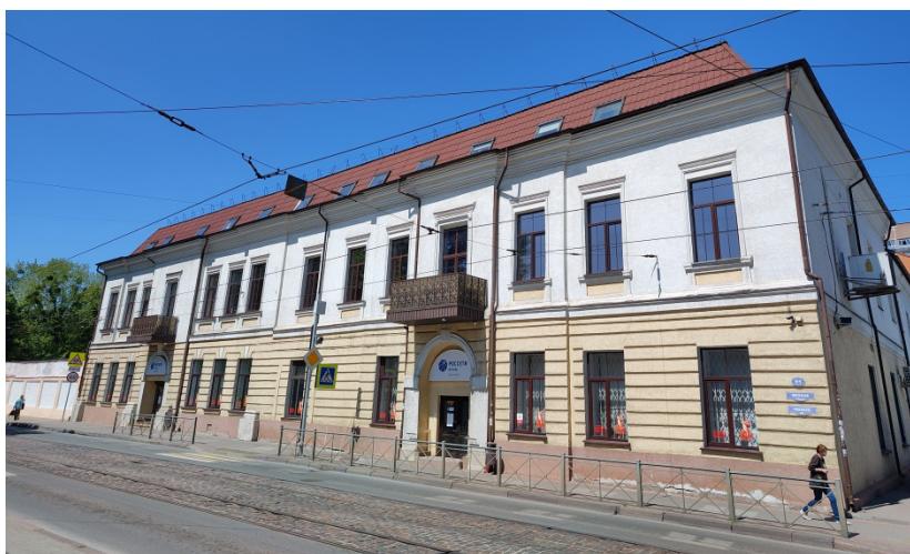
Калининград. Бывший дворец на ул. Фрунзе. Современный вид. Фото Е. П. Мосиенко. 2025
